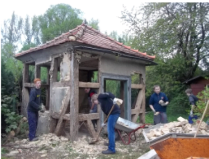
Die Arbeit kommt voran. Die großen Mengen Schutt müssen nun den Weg in die Container finden.
