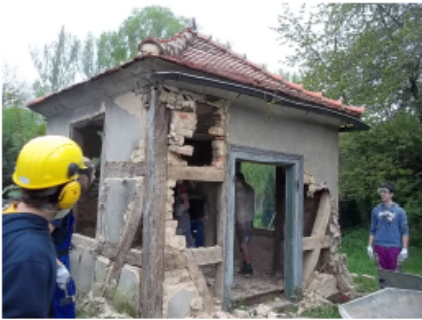
Die Klasse H8a beim Freilegen der Gefache.
