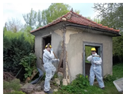
Domenik Pilgram und Leon Schaffland zu Beginn der Abrissarbeiten. Dabei steht der Arbeitsschutz an erster Stelle!
